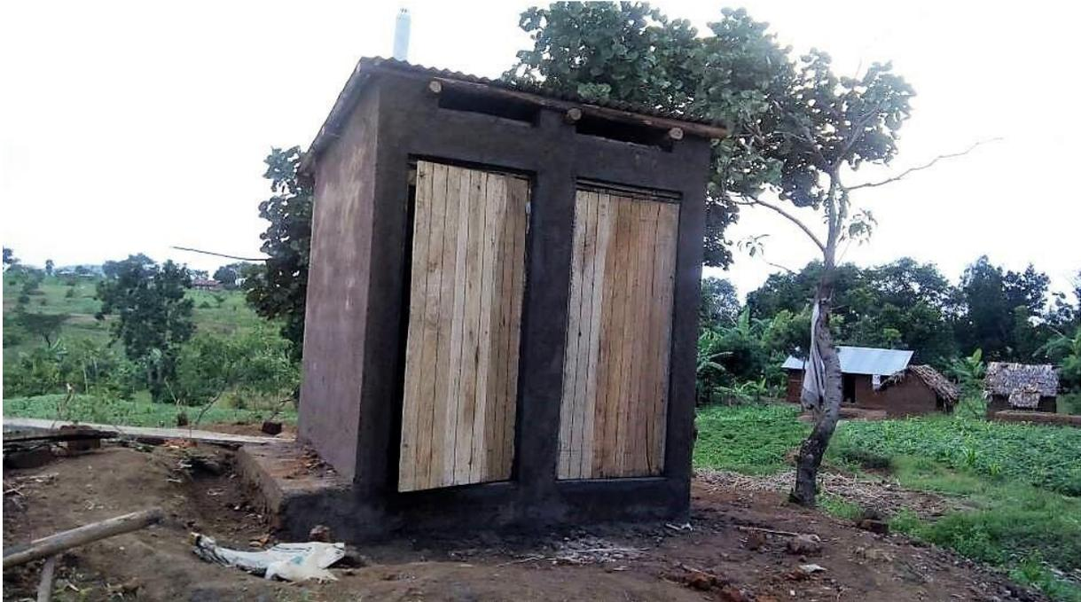
Eine vernünftige Latrine muss tief genug sein und an einem dafür geeigneten Ort stehen. Damit sie auch bei starkem Regen nicht einstürzt, müssen die Wände abgestützt werden. Eine gute Abdeckung, sowie eine einfache "Einhausung", die durchaus auch in traditioneller Weise erfolgen kann, sorgt dafür, dass kein allzu großer Wassereintrag von außen erfolgt. Dazu muss sichergestellt sein, dass das Grundwasser nicht gefährdet wird.
