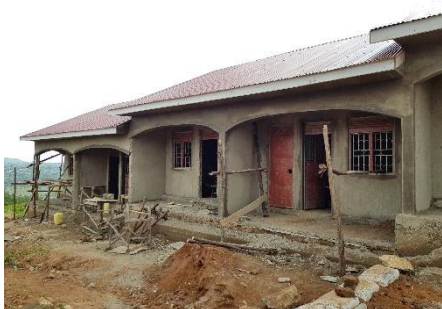
Im Bau befindliche neue Lehrerhäuser
