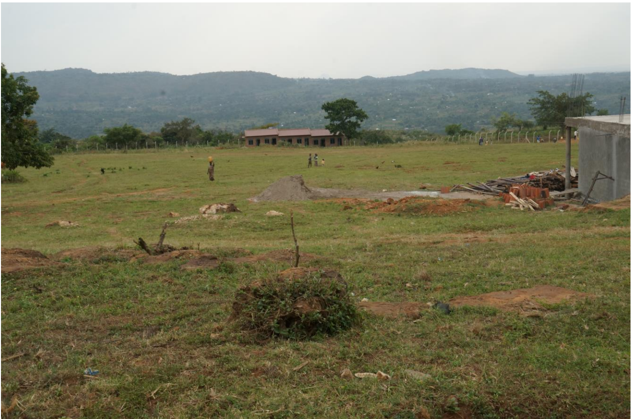
Ein letzter Blick über das Grundstück auf das Lehrer-Kinder-Haus und zum Brunnen (r.u.)
