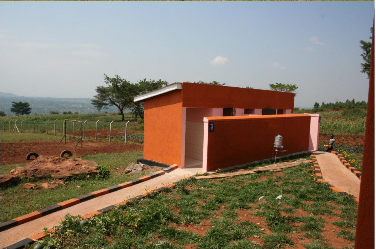
Oben: Das Lehrer-Kinder-Haus , darunter das frisch gestrichene Toilettenhaus.
