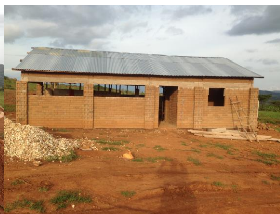
Die fertige „Steinfabrik“
