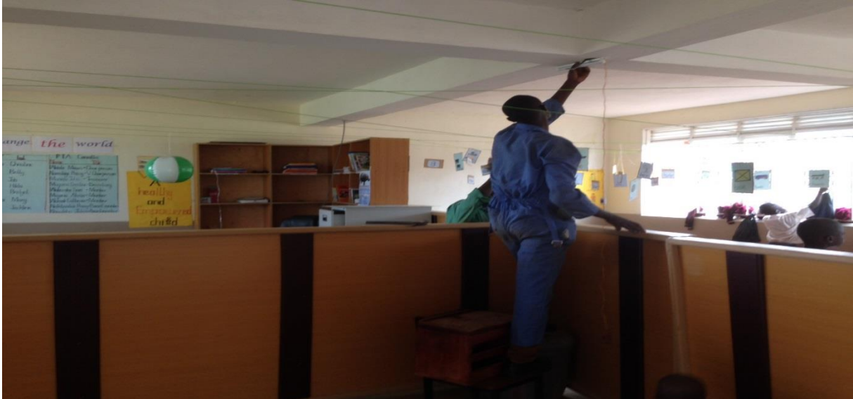
Die Lampe wird angebracht
