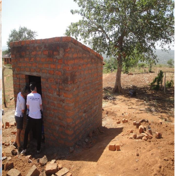
Dagmar und Sabine inspizieren das Pumpenhaus
