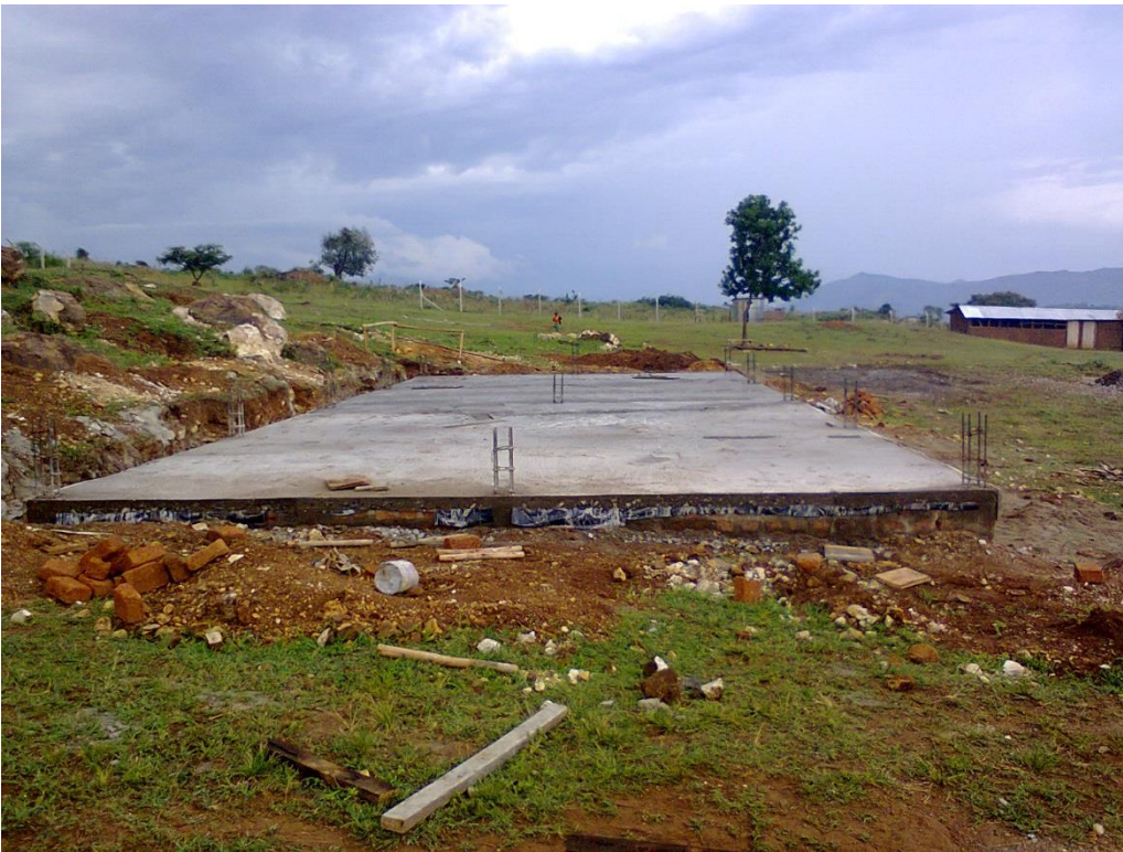
Das fertige Fundament
